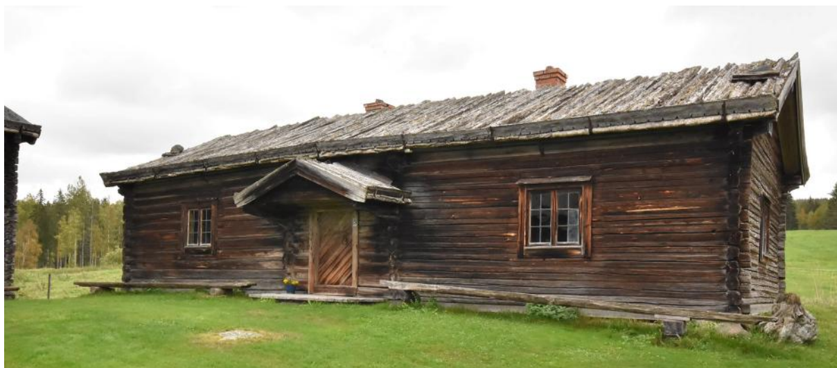
Sätteshus som numera är en parstugan, men ursprungligen byggdes bara den ena halvan. Norrboda Gammelstad.
